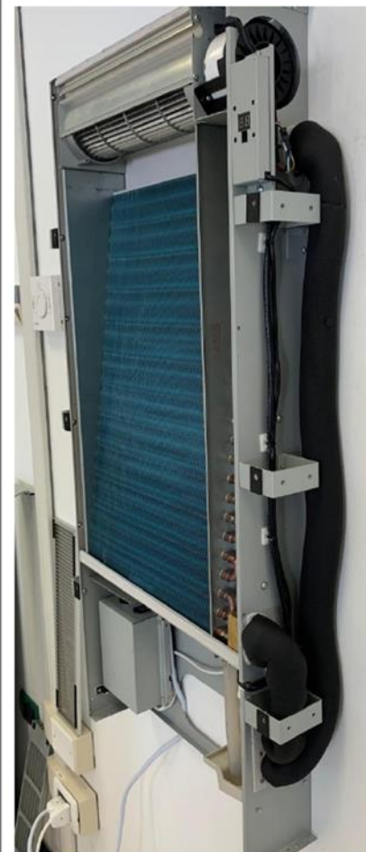
POSIZIONARE ISOLAMENTO ESTERNO DELLE TUBAZIONI
